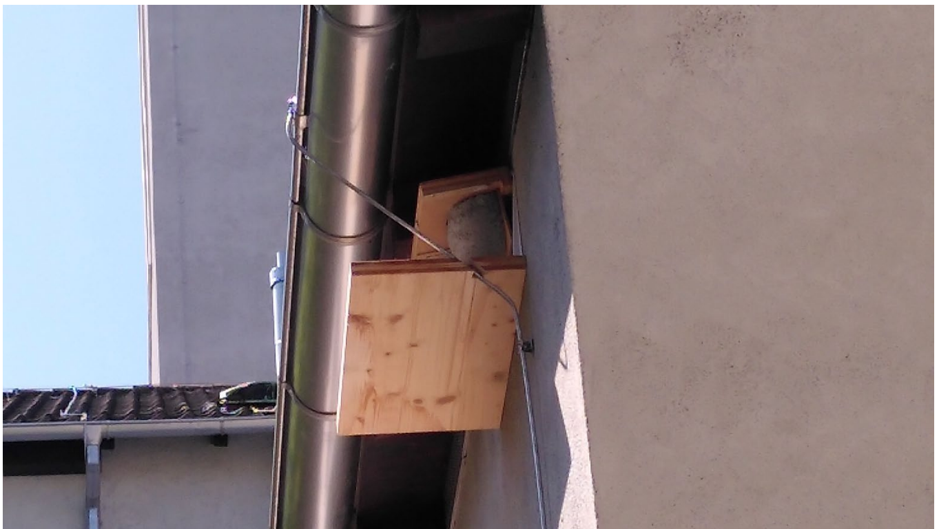
Abb. 6 In diesem Fall wurde die Nisthilfe nicht fachgerecht montiert. Das Kotbrett ist zu gross und zu nahe unter dem Kunstnest für die Mehlschwalbe angebracht. Die Nisthilfe ist somit für die Art nicht nutzbar. Eine fachliche Beratung bei der Anbringung von Nisthilfen erhöht die Besiedlungswahrscheinlichkeit. © Stephanie Michler
